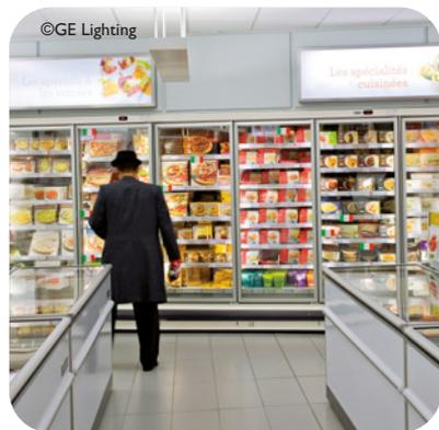
Dans les meubles réfrigérés, il faut veiller, en utilisant des luminaires aux optiques adaptées ou des réglottes, à ce que la source de lumière ne soit pas directement visible, ce qui permet de réduire l'éblouissement. Les sources à LED, qui dégagent peu de chaleur, sont bien appropriées : le gaspillage d'énergie en zone froide est d'autant plus limité. Il existe aussi les tubes fluorescents aux amalgames présentant des propriétés similaires.
